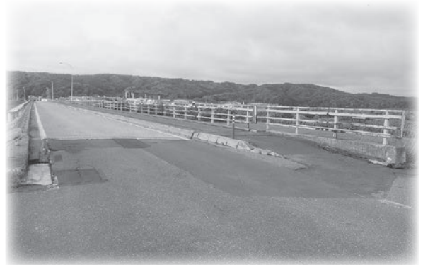
田代橋の様子
