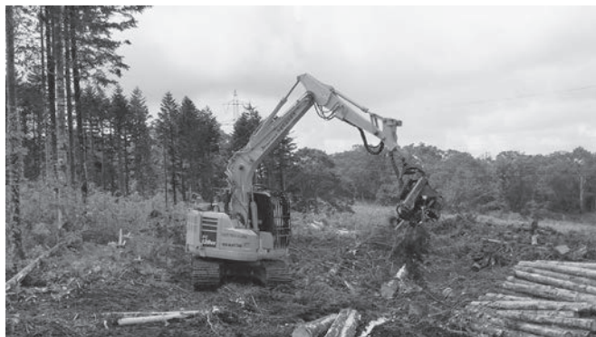
町有林伐採工事の状況（奥沢地区）
