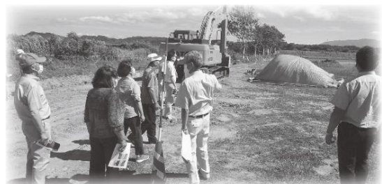
今金中学校建設予定地の様子
