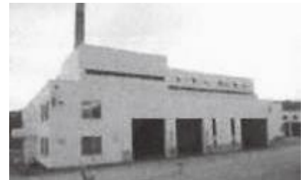
北部松山衛生センターの様子
