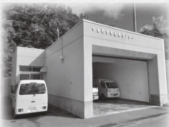
改築予定の学校給食センター
