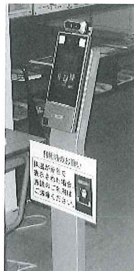
温度測定顔認証端末機 (町民センター入口に設置)
