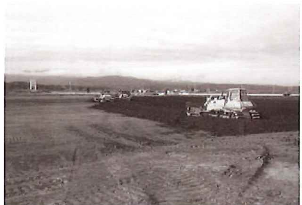
区画整理工事の様子
