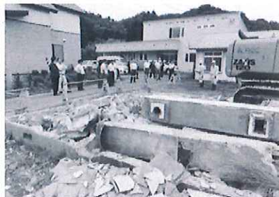
栄団地町有住宅解体工事
