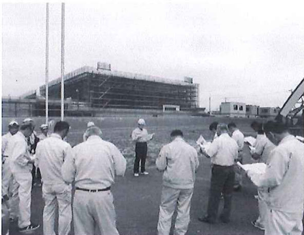
総合体育館建設工事の進捗状況について説明を受けている様子
