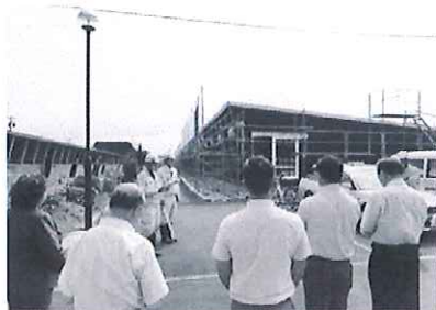
緑団地町営住宅屋根・外壁塗装工事
