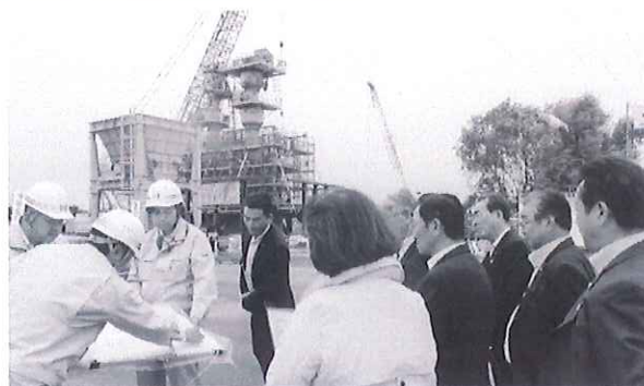
今金橋架け替え事業工事現場の様子
