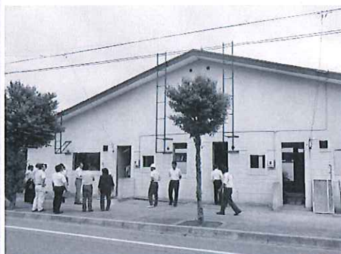
南栄町地区町営住宅改修工事
