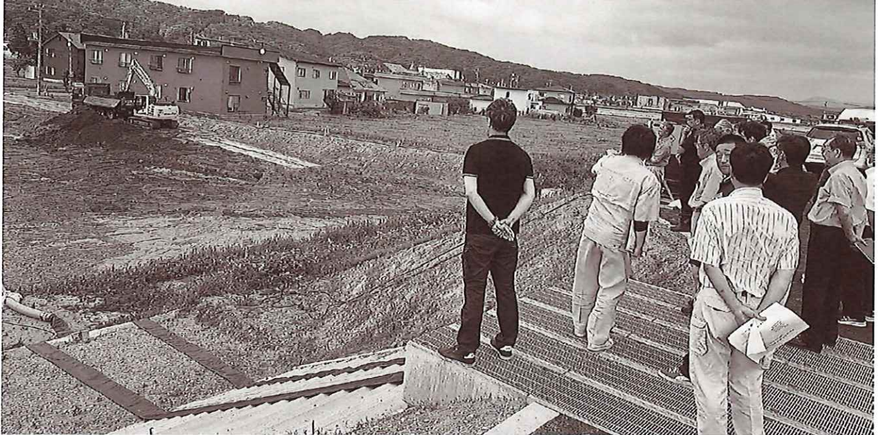
第二幹線川貯水池整備の状況
