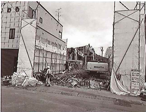
旧マーケット解体状況
