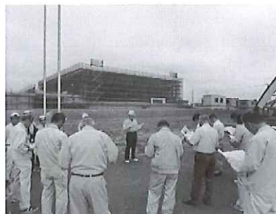
新総合体育館建設工事の進捗状況
