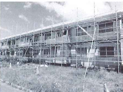
南団地町営住宅屋根塗装工事
