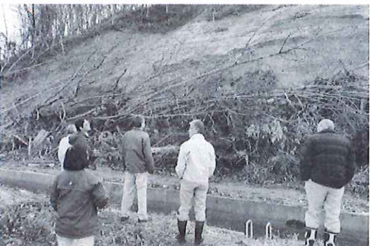
稲穂地区の地滑り現場
