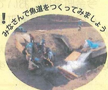
丸太を使って壁をつくる。水深を確保する。流速を遅くする。
