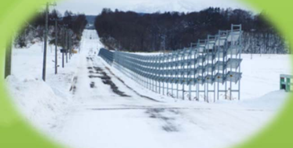
八東高台線防雪柵 設置工事
