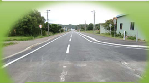
イマヌエル線 交付金工事
