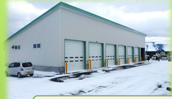
雪寒機械等車庫整備
