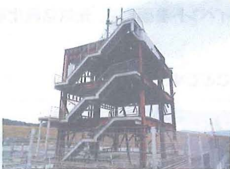
南三陸町防災対策庁舎跡
